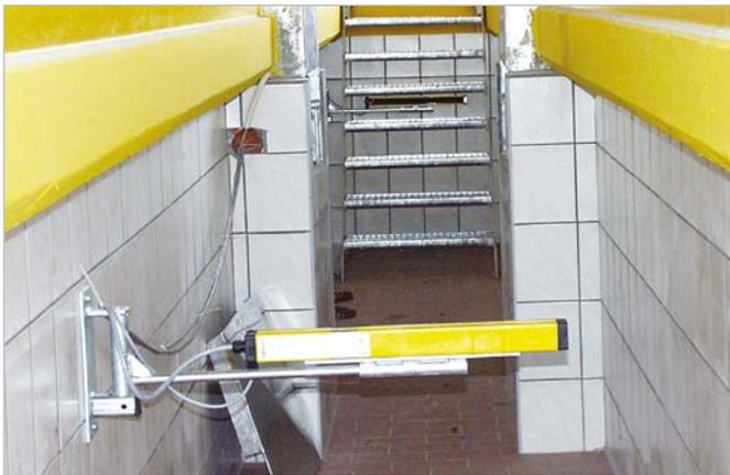
Bei Montage der Rollensätze über einer Arbeitsgrube ist der Gefahrenbereich mit einer Grubensicherung abzusichern. Die Rollensätze werden bei Betreten des Gefahrenbereiches sofort stillgesetzt.
